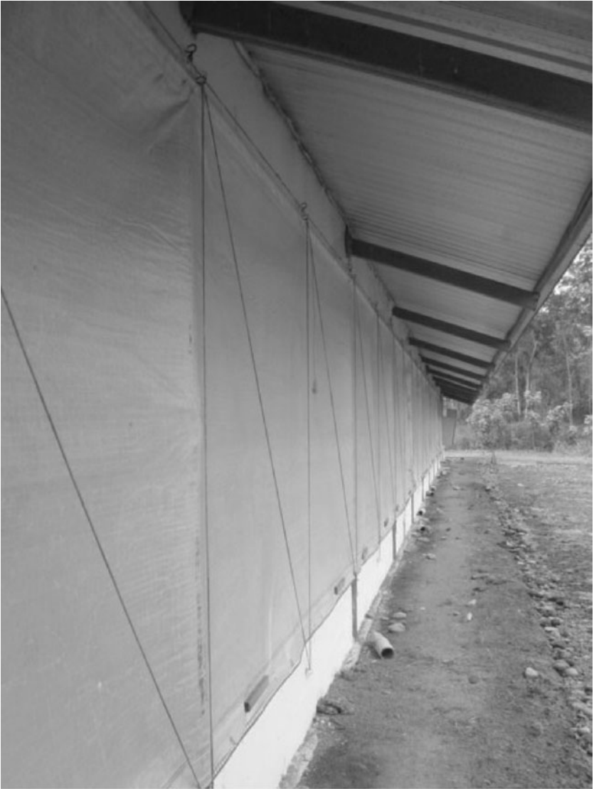
Fig. 5.8. 1.2-m roof overhang.
